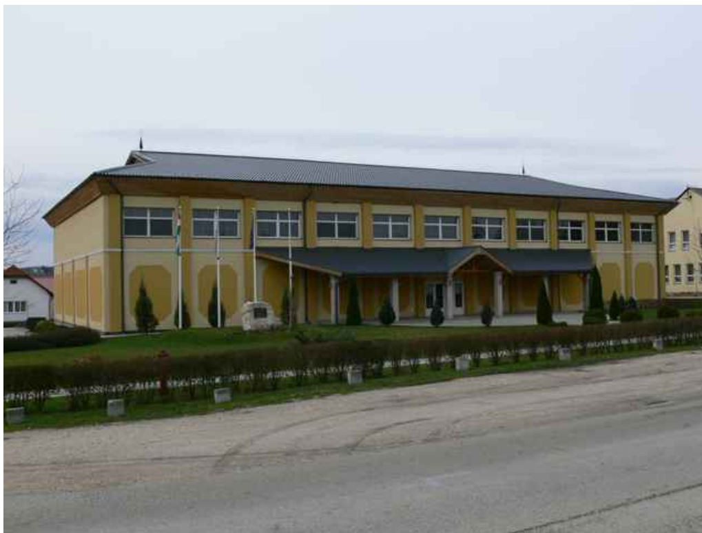
3. kép. Közösségi beruházások: a 2002-ben épült tornacsarnok (A szerző saját fotója, 2008)
